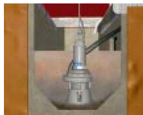
Насос с внутренней системой охлаждения
